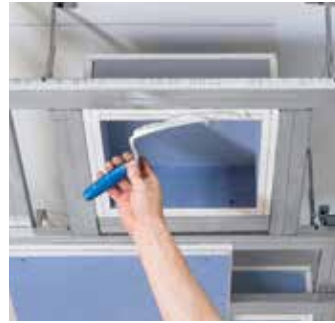
Knauf Uniflott allseitig an Brandschutzhaube auftragen.
