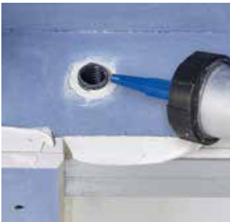
Bei Eintritt von elektrischen Leitungen, Fehlstelle mit Knauf Uniflott ausspritzen/anspachteln.
